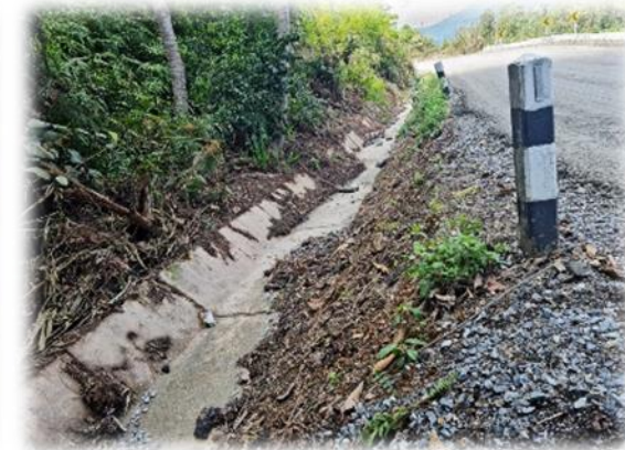
รางระบายน้ำ
