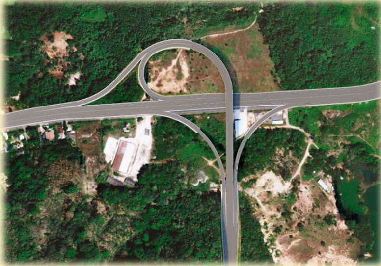
จุดตัดทางหลวงสายหลัก
