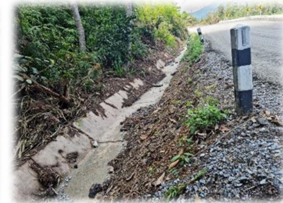
รางระบายน้ำ
