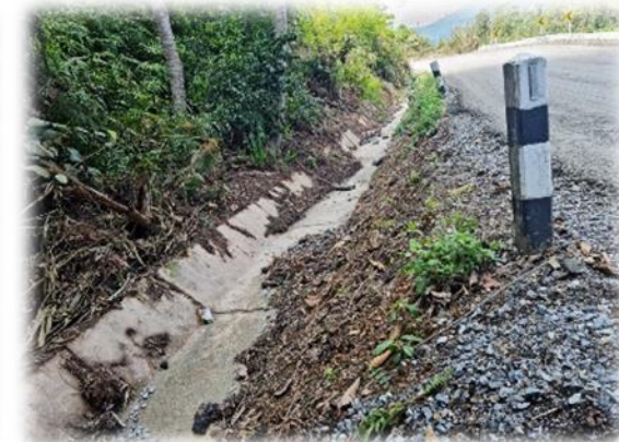
รางระบายน้ำ
