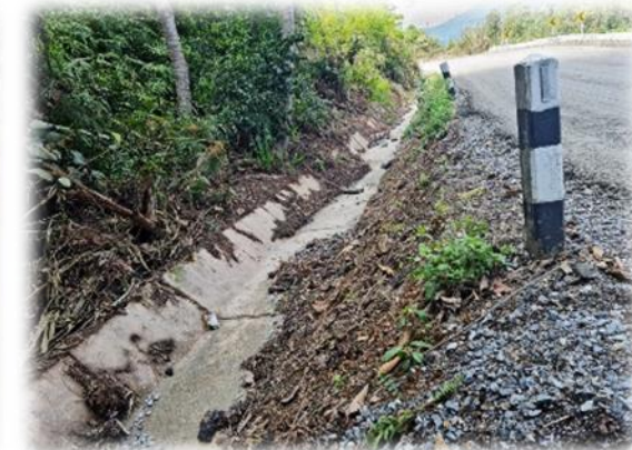
รางระบายน้ำ
